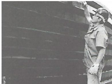
**7. PEÇA LATERAIS DE FECHAMENTO:** Assentados os módulos (peça inteiras e meia peças) devem ser instaladas as peças laterais de fechamento. Estas possuem função, sendo 1) drenagem do excesso de água proveniente irrigação ou chuva, 2) fechamento dos módulos cerâmicos nas extremidades e 3) passagem oculta da canula que irá alimentar o sistema de irrigação por gotejamento.
